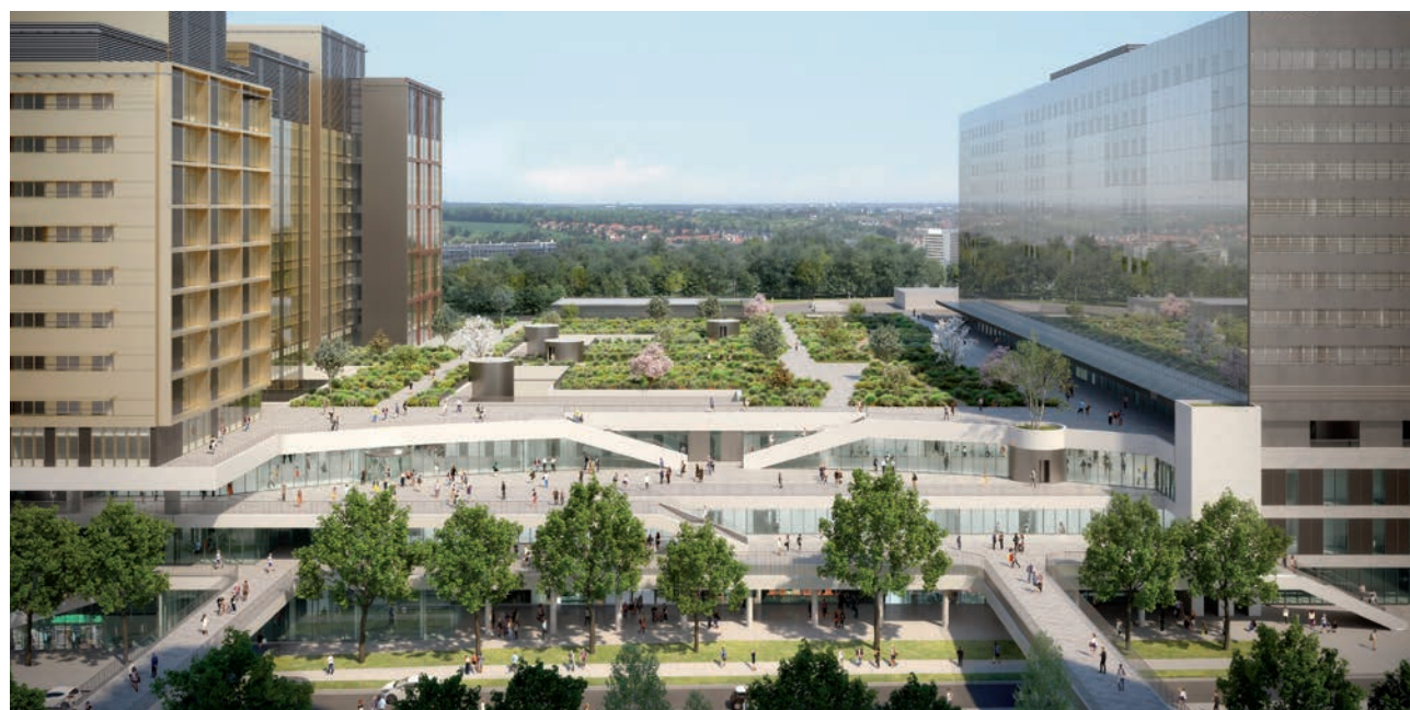
La démolition de bâtiments existants permettra de libérer de l'espace pour la construction d'une nouvelle tour d'hospitalisation et la création du «Jardin des Cliniques».
